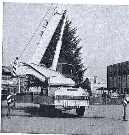
Ampia area stabilizzata
